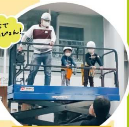
9 高所作業車体験
